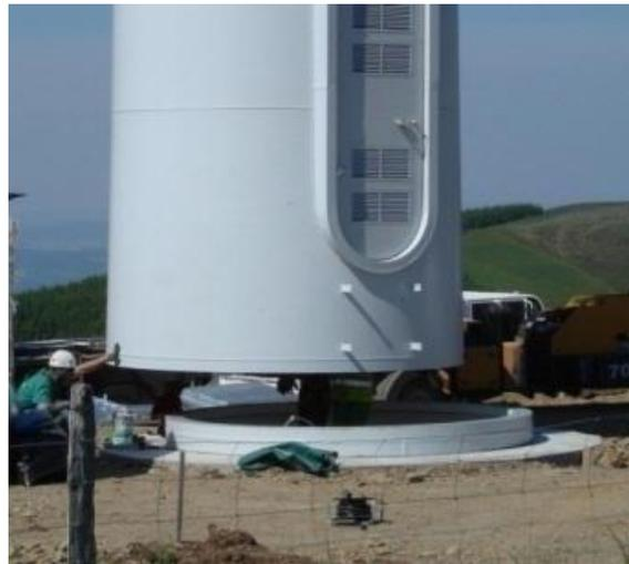
Figure 31 : Installation du mât sur la fondation
