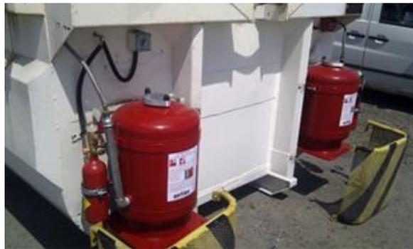
Figure 46 : Exemple de dispositif d'extincteurs
