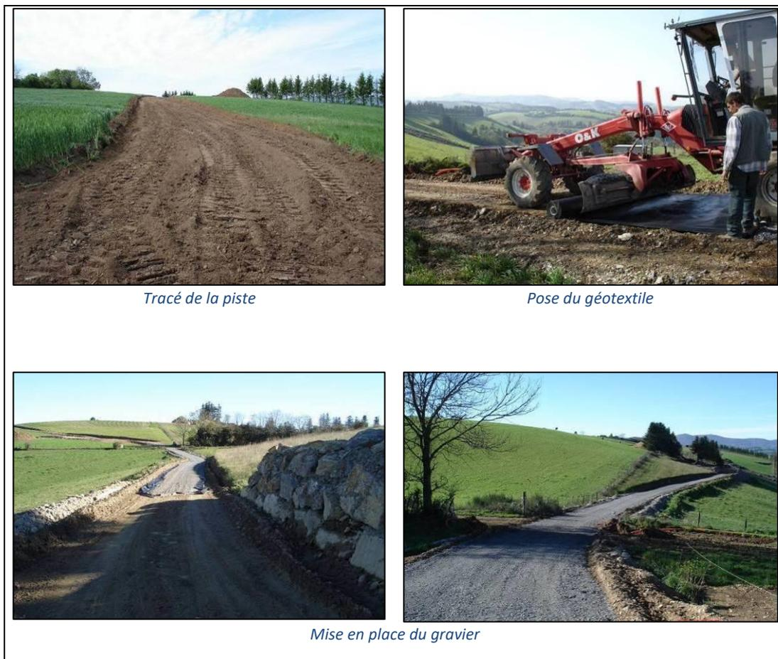
Figure 32 Exemple de réalisation de pistes
