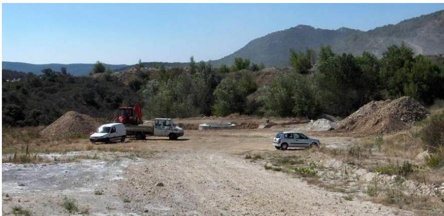
Figure 38 : Stockage des matériaux excavés en bordure de la plateforme à Saint Arnac (66).
